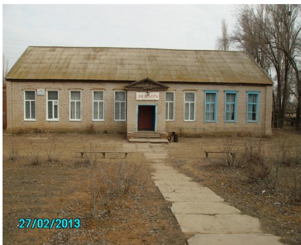
Здание Дома Культуры
